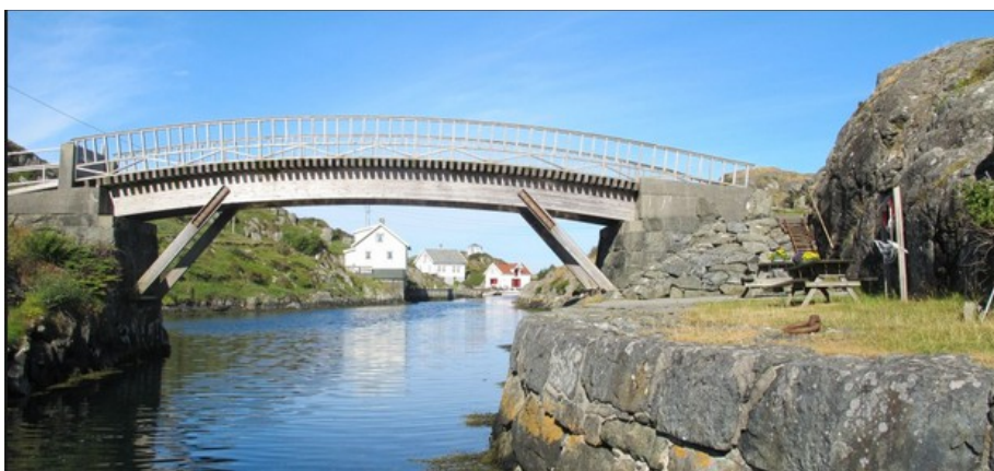
Fra Feøy kanal ved rasteplassen. Kanalen stod ferdig i 1909. Den er 200 meter lang, 10 meter bred og 3-4 meter dyp. Kanalen og området rundt er regulert til spesialområde for bevaring. ( Kulturminner i Karmøy )
